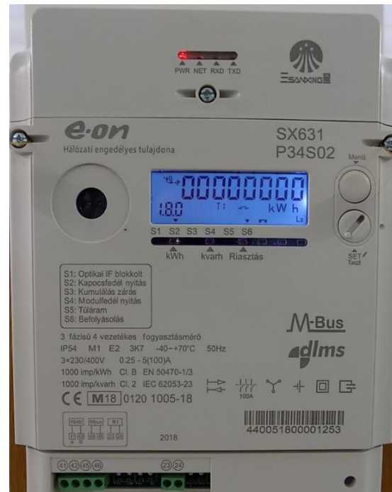
3 fázisú, típusa, SX631 P34S02 3x5-100 A 8 egész 0 tizedes a felbontás Kommunikáció: GPRS.
