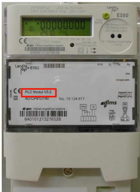
1 fázisú, típusa, E350 5-80 A 6 egész 1 tizedes felbontás Kommunikáció: PLC.
